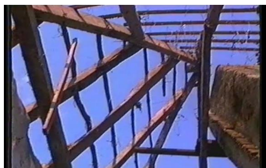
Schoorsteen en wolfseind
