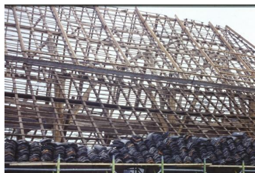
Dakconstructie met stalen balk
